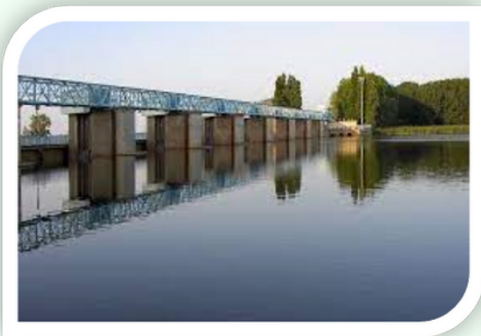
PRESA DE SAN JOSÉ
