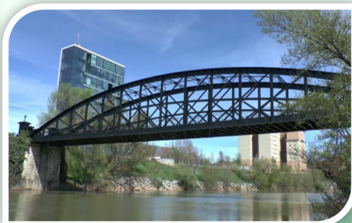
PUENTE DE HIERRO
