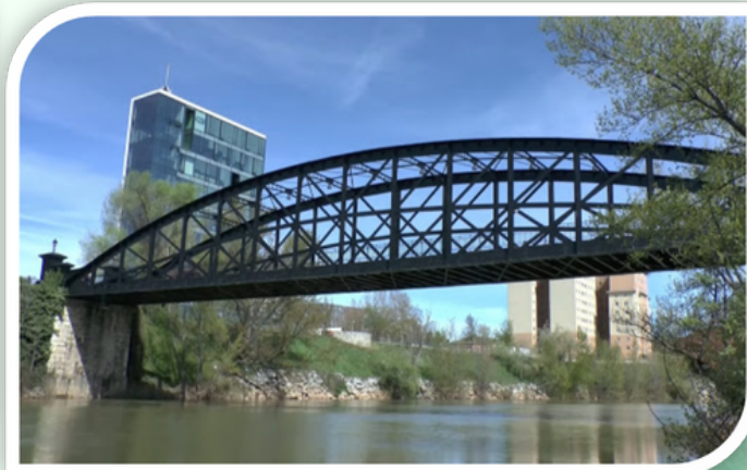
PUENTE DE HIERRO
